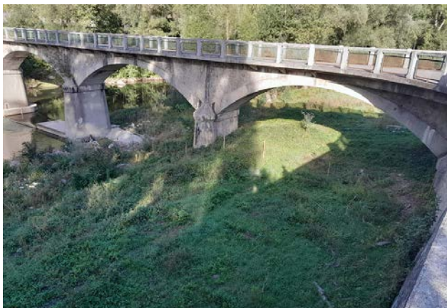
Instal·lació d'una tanca amb estaquetes i doble filat, al Roig, a Ripoll
