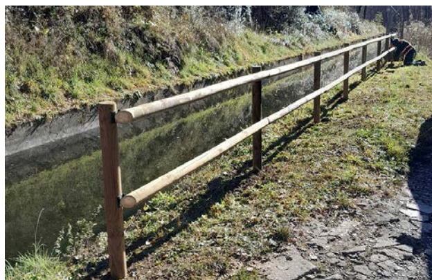
Instal·lació de 18 metres de tanca texana al pas de la Ruta del Ter, Ripoll
