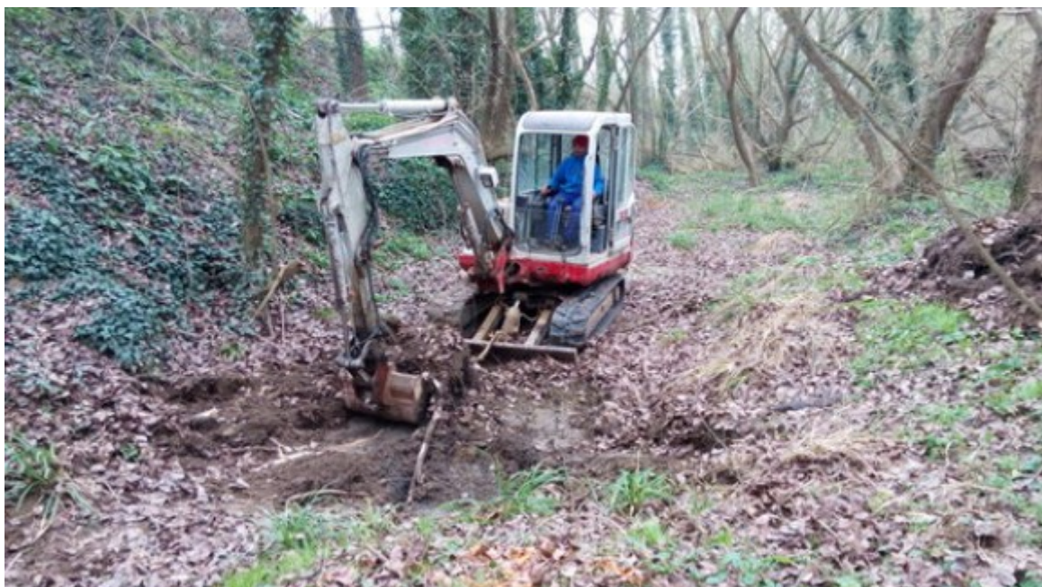
Una retroexcavadora treballa per crear una de les basses que s'han construït a Flaçà
