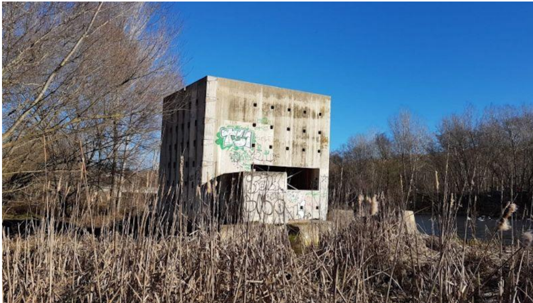
Un exemple del refugi de ratpenats instal·lat a Fontajau | Consorci del Ter
